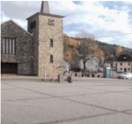
Erneuerung des König-Baudouin-Platz in Schönberg
