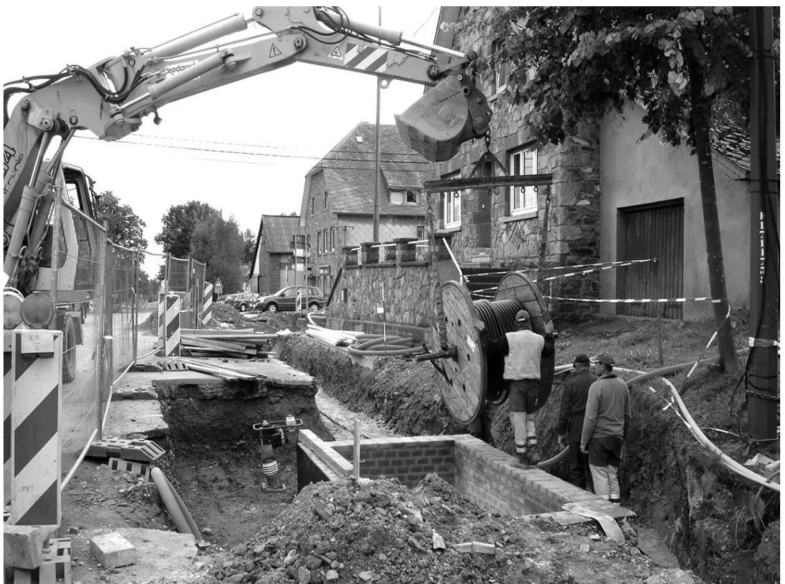
Unser Bild zeigt das Verlegen der Stromleitungen
