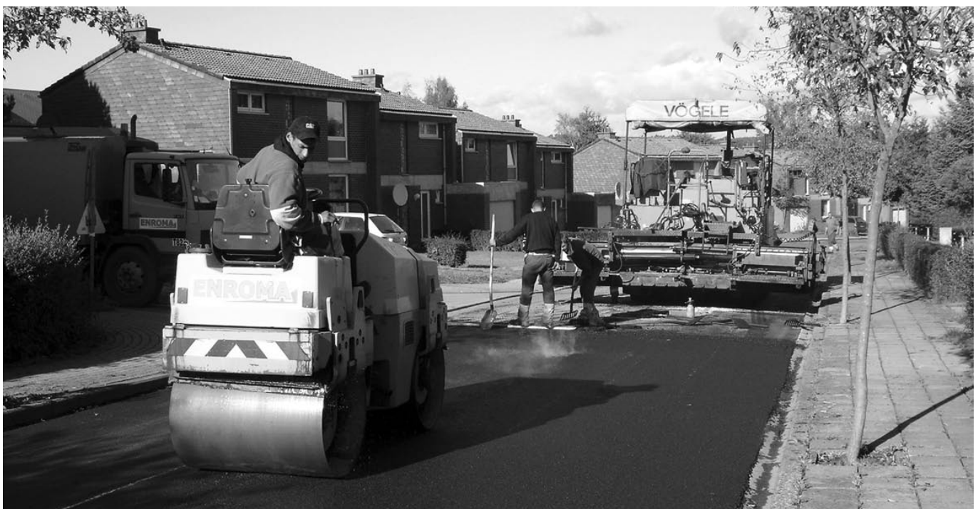
Verlegung der neuen Asphaltdecke in der Silvio-Gesell-Straße in St.Vith.
